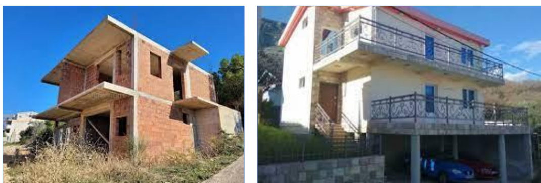
Slika 2.12c. Primjer zidanih stambenih objekata sa AB ramom koji su izgrađeni poslije 1981. godine na teritoriji opštine Bar.
